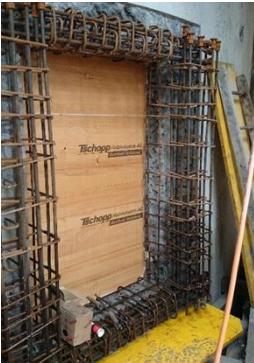
Stahlbeton, Drucktürenbewehrung
