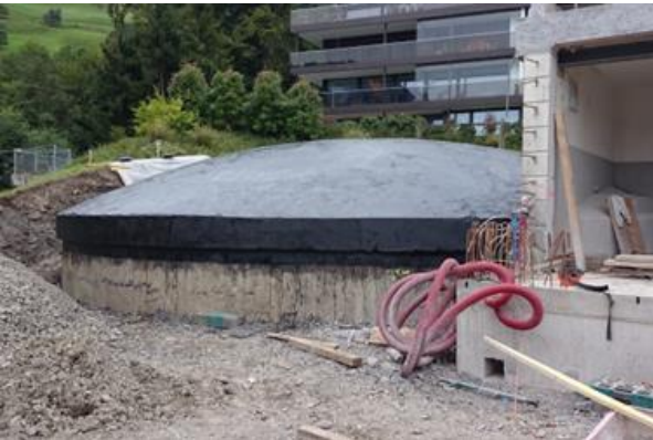
Bituminöse abgedichtete Decke der Kammer
