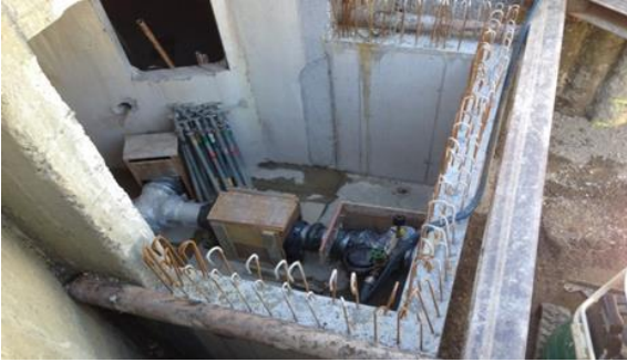
Aussenwände im UG mit ersten Rohrinstallationen
