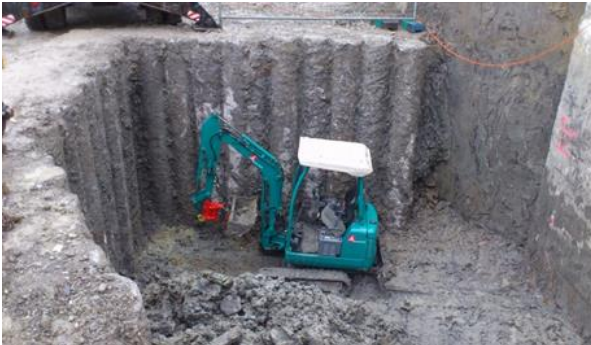
Baugrubensicherung mit Bohrpfehlwand, Aushubarbeiten
