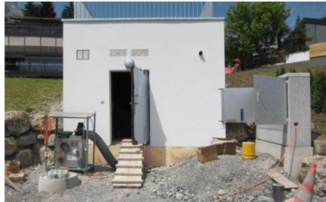
Ansicht Aussenfassade nach Isolation & Verputz
