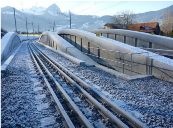
Neue Brücken der Zentralbahn
