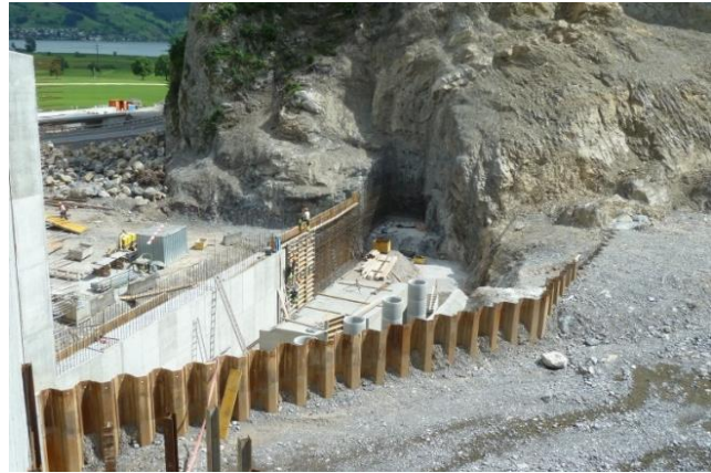
Geschiebesammler während dem Bauzustand
