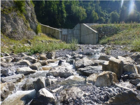
Bachlauf bei passierbarer Blockrampe
