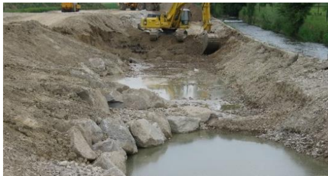
Aufweitung mit Einbau der Buhnen
