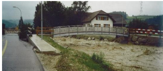
Ufersicherungen; Belastungsprobe standgehalten
