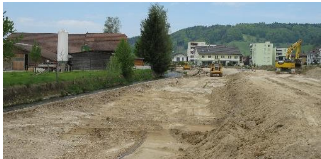
Realisierter neuer Gewässerraum von 26m
