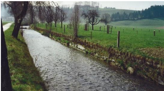
Trapezgerinne; Betonleitwerke Baujahr 1930
