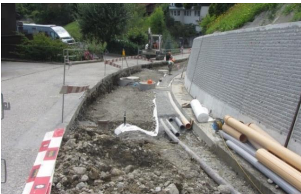
Neue Stützmauer mit Struktureinlagen
