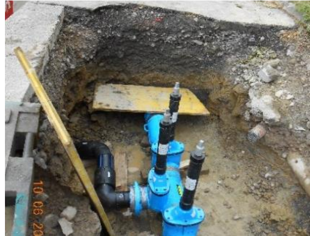
Schiebekreuz der Wasserleitung
