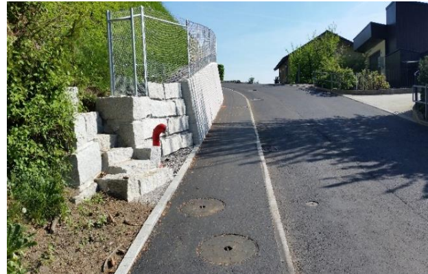
Neues Trottoir und Strasse
