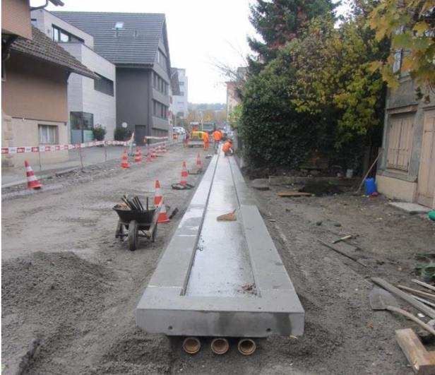
Versetzen der vorgefertigten Betonelementen (Bachschale)
