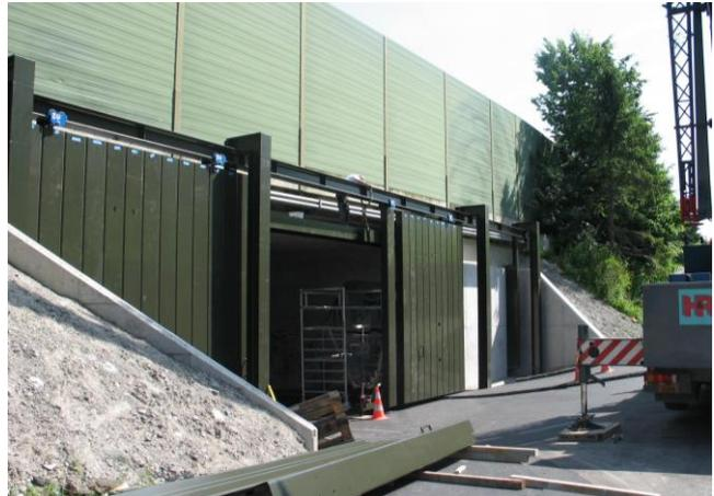
Hochwasserschutztor bei der Autobahnerunterführung
