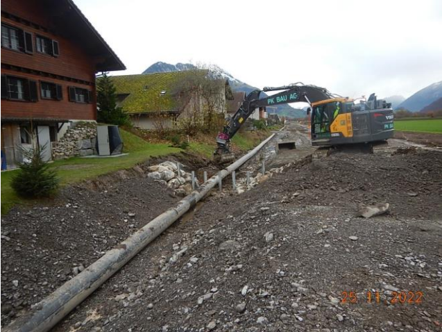
Schöpfgraben während der Bauphase mit Wasserhaltung
