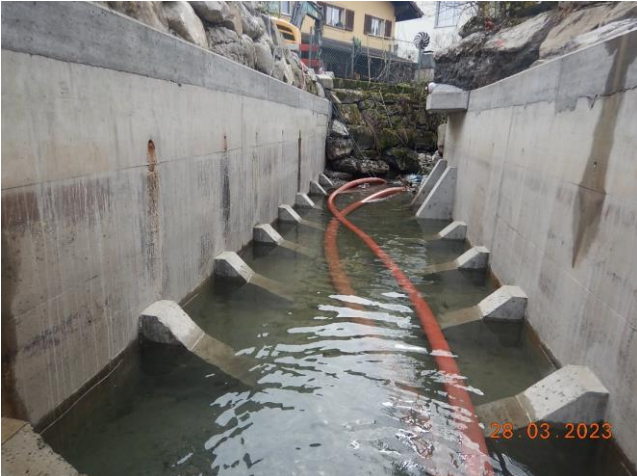
Offengelegter Durchlass Schützenmatte im Giessenkanal
