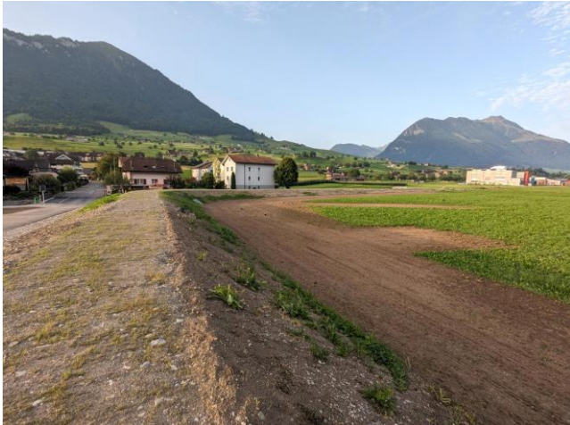
Aufgeschütteter Damm mit Kettstrasse
