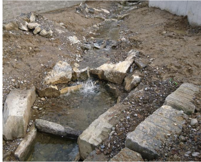
Einlaufbereich Durchlass Kontonsstrasse
