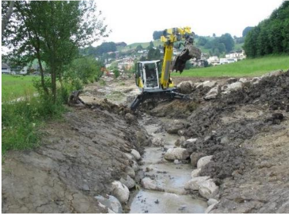
Aushubarbeiten für die Bachgestaltung
