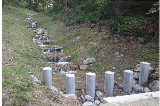
Revitalisierter Bachlauf mit Holzrechen
