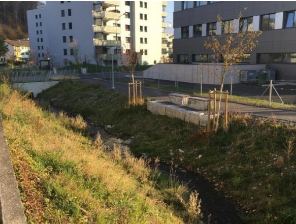
Revitalisierter Bachlauf mit Sitzgelegenheiten
