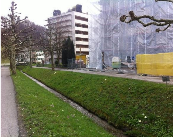
Kanaliseierter Bachlauf, vor Massnahmen
