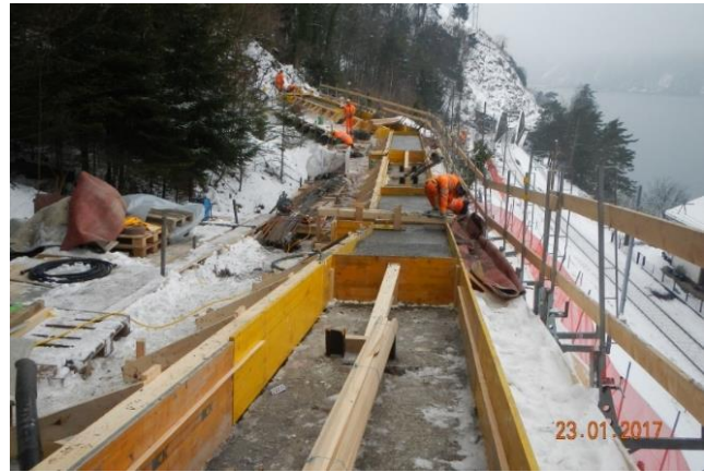
Betonierarbeiten für Fundation Schutznetzanlage
