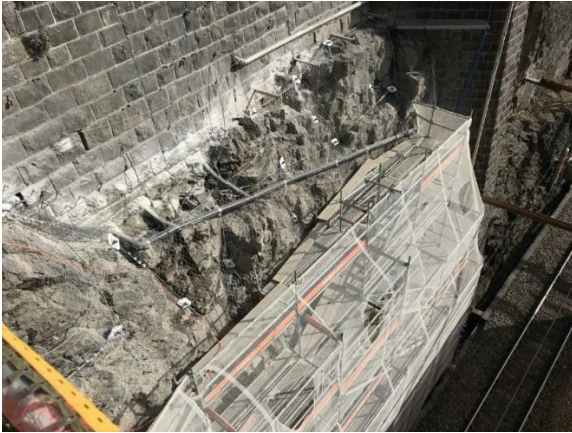
Ankerarbeiten ab Gerüst unter Bahnbetrieb
