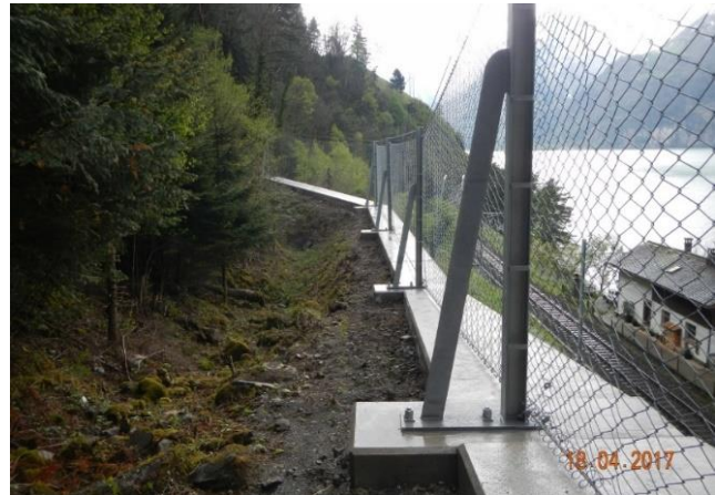
Fertiggestellte Schutznetzanlage
