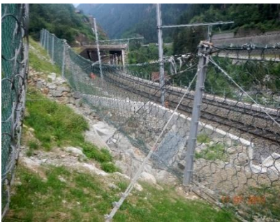
Schutznetze beim Bahntrassee
