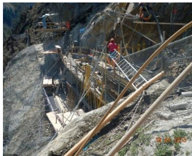
Arbeiten im Fels
