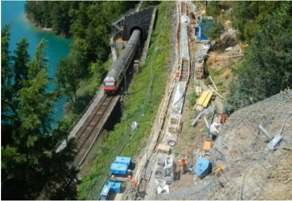
Ertüchtigungsarbeiten am Schutzbauwerk unter Bahnbetrieb
