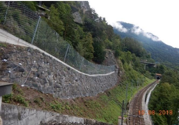
Fertiggestellte Schutznetzanlage auf Schutzdamm oberhalb der Bahnlinie
