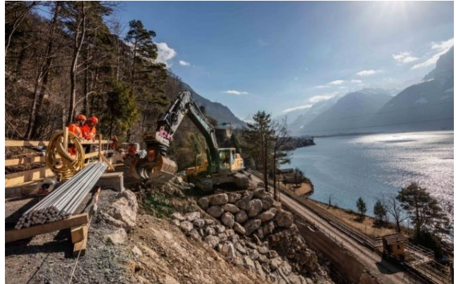
Rückbau der Schutzbauwerke und Instandstellen des Bachgerinnes
