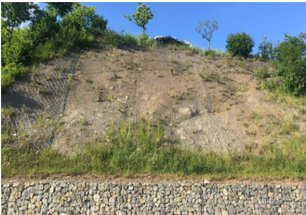
Ansicht Hangverbau mit Steinkorbmauer
