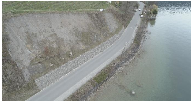
Luftbild Hangverbau mit Steinkorbmauer
