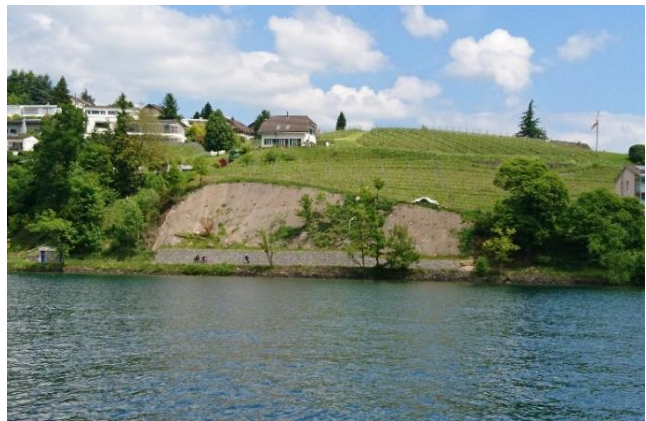
Ansicht Hangverbau mit Steinkorbmauer
