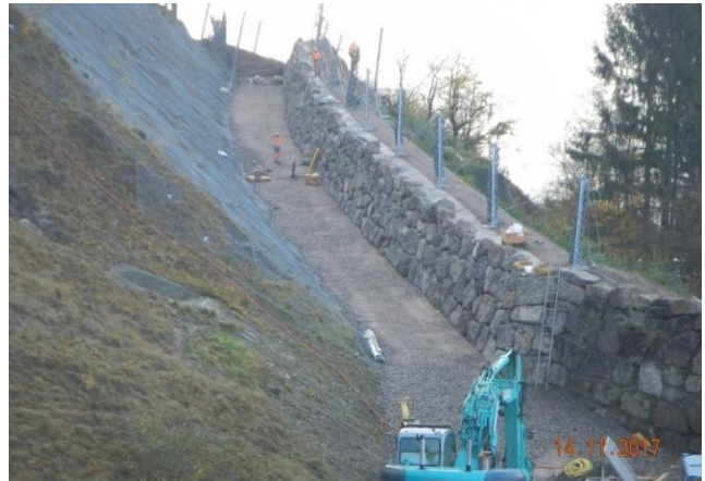
Schutzdamm mit Räumungspiste
