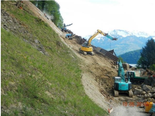
Abtrag und Böschungssicherung in Etappen
