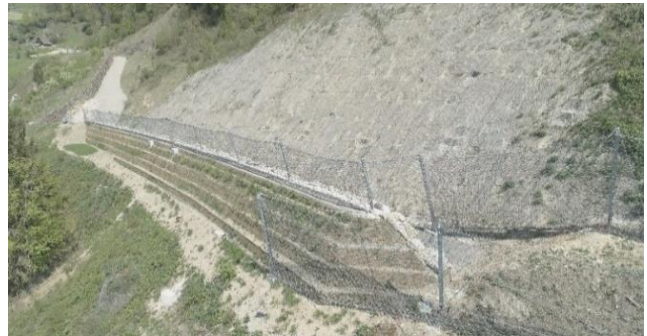
Schutzdamm / Schutznetze nach Massnahmen
