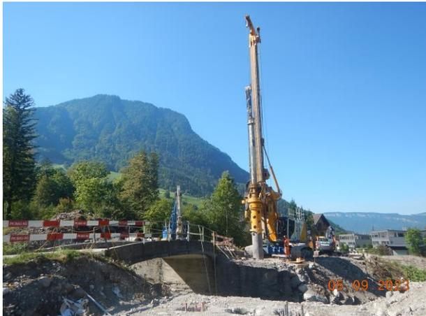
Bohrarbeiten für die neuen Brückenwiderlager
