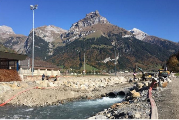
Wasserhaltung für Blocksatzverbau
