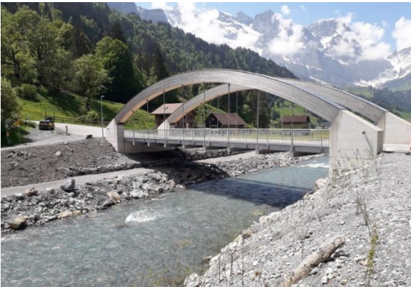
Neue Ziegelbrücke infolge der Verlegung der Engelberger Aa
