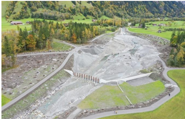
Neuer Geschiebe- und Holzrückhalteraum Bannwald
