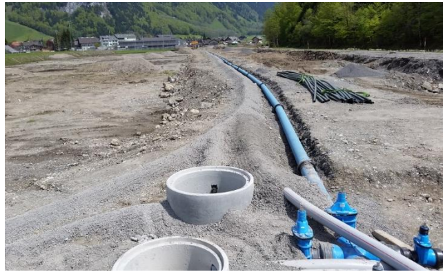
Zahlreiche Werkleitungsverlegungen infolge der Wasserbaumassnahmen
